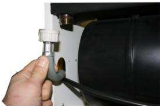
3 Collegare il tubo scarico condensa.
