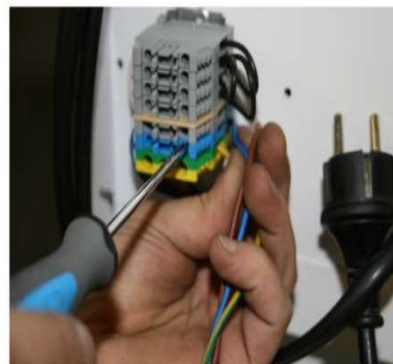
5 Connettere i cavi di alimentazione e dell'eventuale umidostato remoto.
