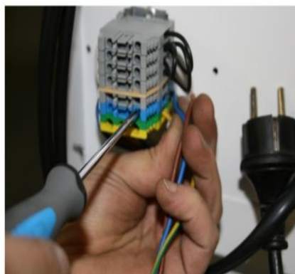
5 Anschließen der elektrischen Leitung und verdrahten der Fernbedienung.
